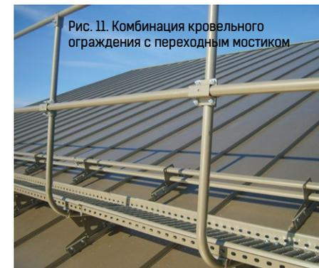
Рис. 11. Комбинация кровельного ограждения с переходным мостиком
