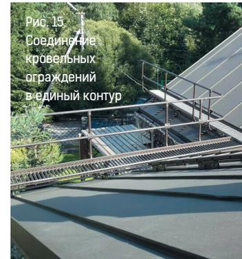
Рис. 15. Соединение кровельных ограждений в единый контур
