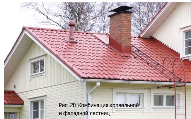
Рис. 20. Комбинация кровельной и фасадной лестниц
