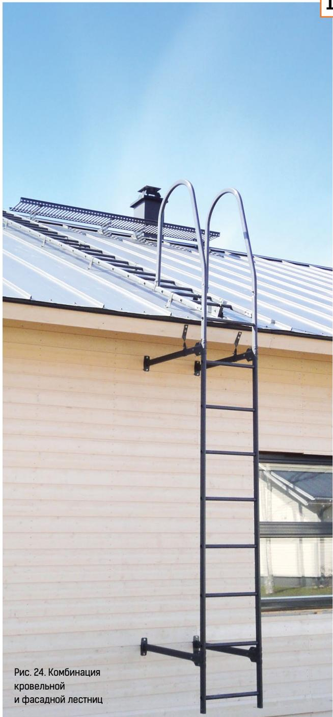
Рис. 24. Комбинация кровельной и фасадной лестниц
