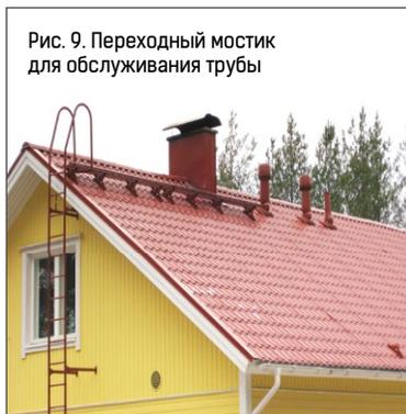
Рис. 9. Переходный мостик для обслуживания трубы
