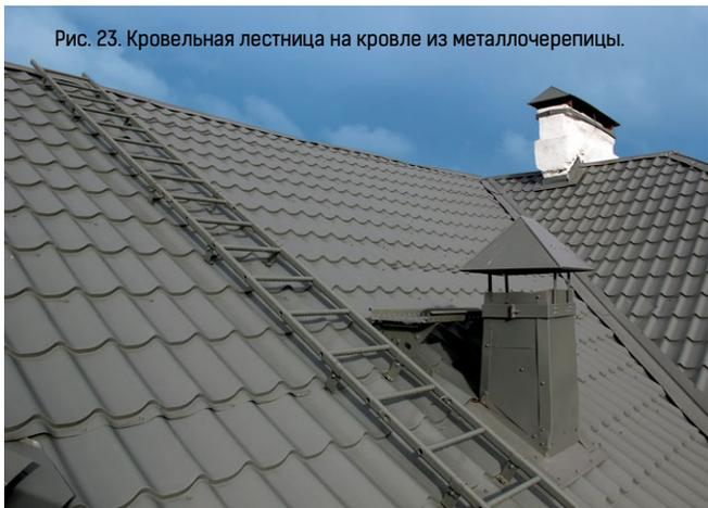
Рис. 23. Кровельная лестница на кровле из металлочерепицы.
