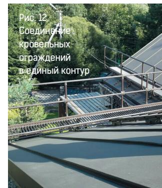
Рис. 12. Соединение кровельных ограждений в единый контур
