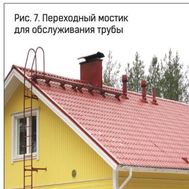
Рис. 7. Переходный мостик для обслуживания трубы
