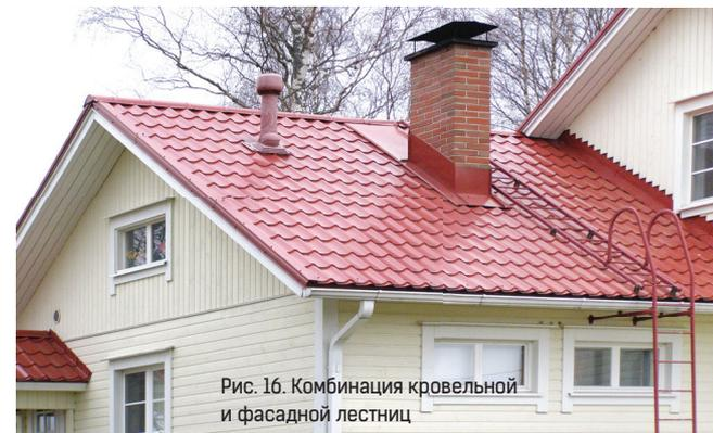
Рис. 16. Комбинация кровельной и фасадной лестниц
