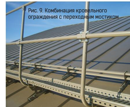
Рис. 9. Комбинация кровельного ограждения с переходным мостиком
